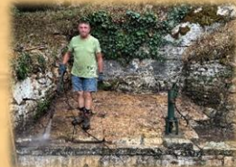
Nettoyage du lavoir
