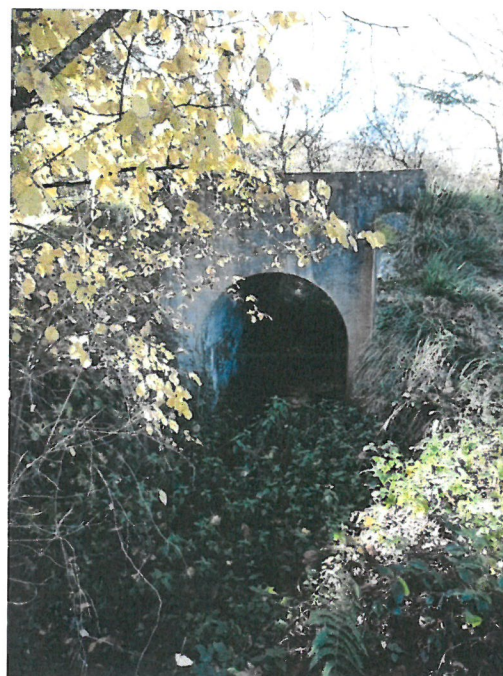
Pont maçonnerie sur la route de Samatan
