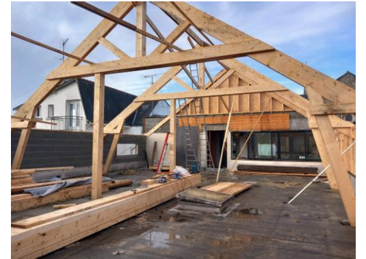
Montage de la future charpente
