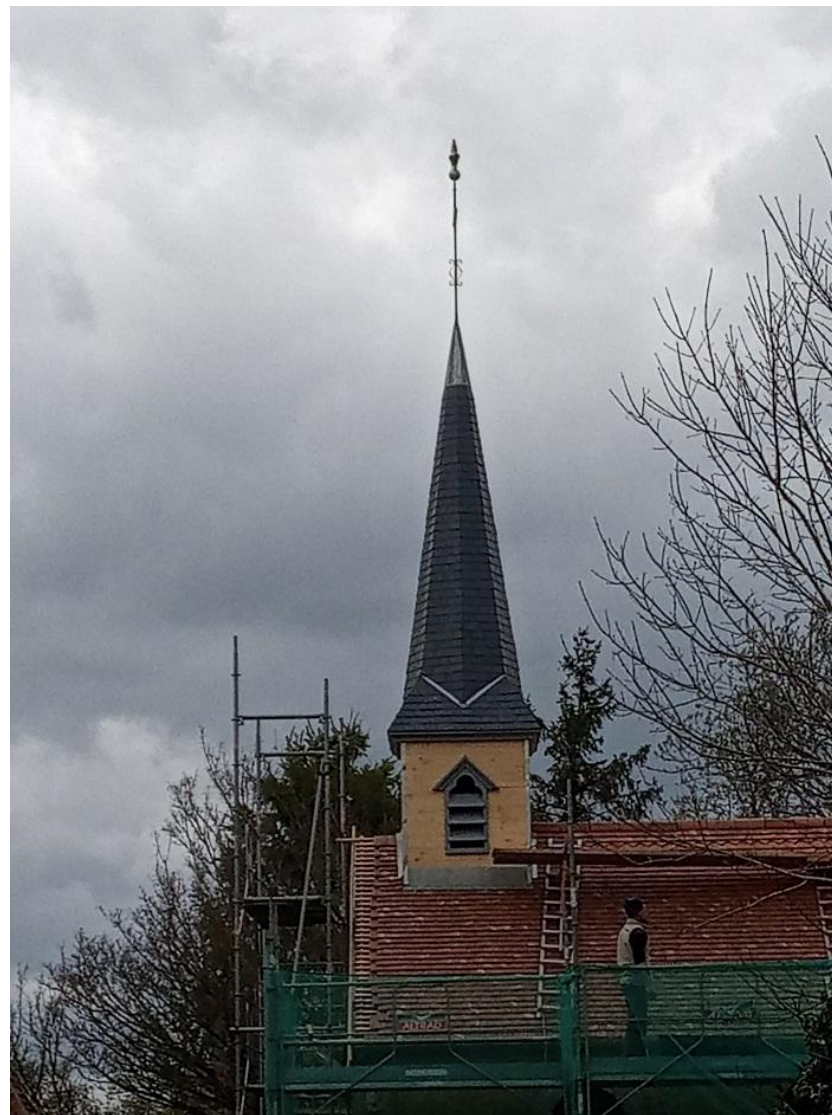
Volige sur la partie inférieure du clocher avant pose de ardoises
