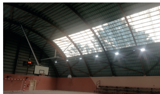
Installation des leds dans la salle des sports
