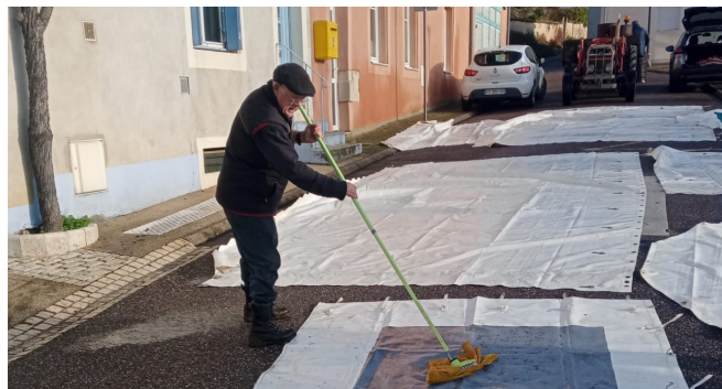
On nettoie avant la mise en place
