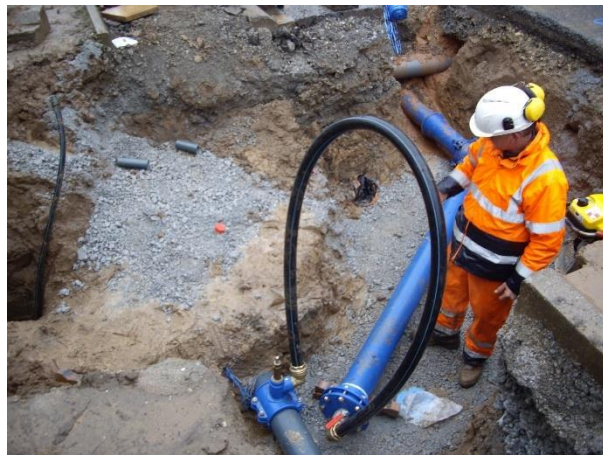
Travaux réalisés en régie par les équipes du SPEHA
