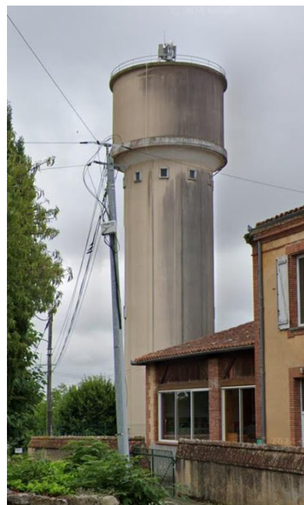
Réhabilitation du château d'eau de Lagarde (en cours)
