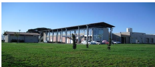
Usine d'eau potable de Calmont
