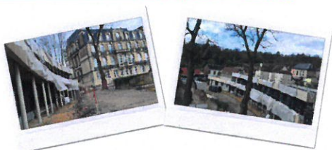
Création d'un nouveau bâtiment d'hébergement pour le Foyer de Vie de Flixecourt
