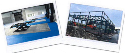
Création station de lavage véhicule d'occasion et véhicule neuf pour l'ESAT d'Abbeville
