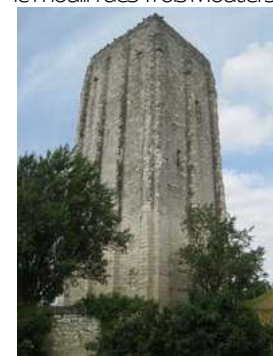
la Tour Carrée
