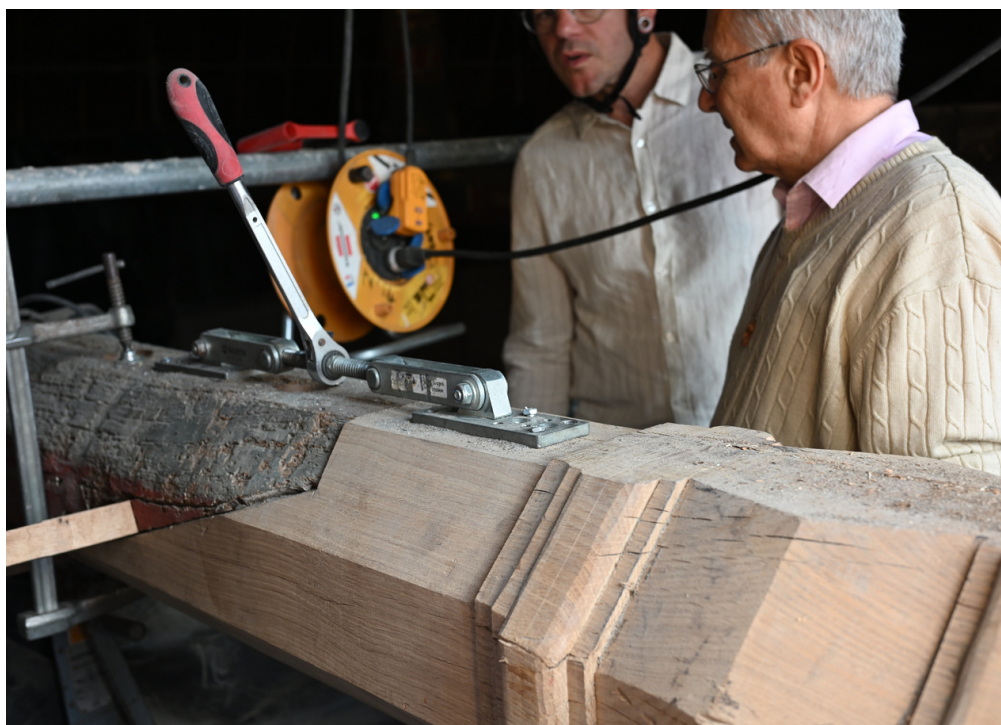
Le père Cordier vient observer la réfection, à l'identique, d'un entrail côté sud, détérioré par l'humidité.
