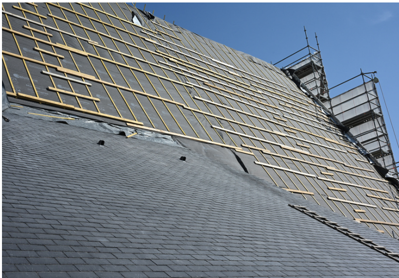
Chapelle couverte et pare-vapeur sur la nef.
