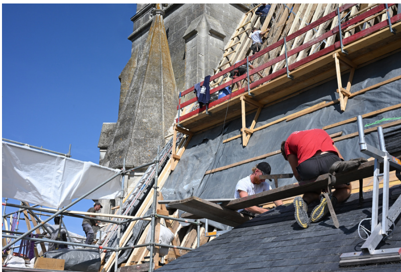
Charpentiers, couvreurs et maçons à l'oeuvre.
