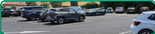
Réaménagement du parking place Bouqueyre
