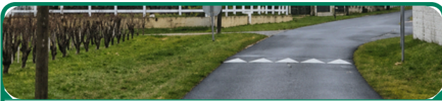
Réfection et sécurisation route de Jauge Blanc
