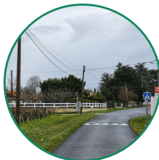
Réfection de la route de Pin de Fleur
