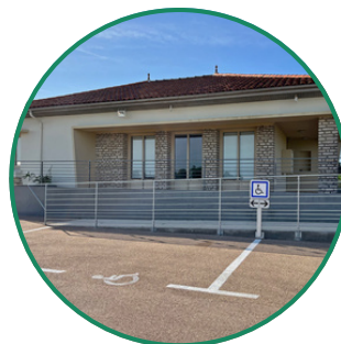
Réfection de l'ancien cabinet vétérinaire
