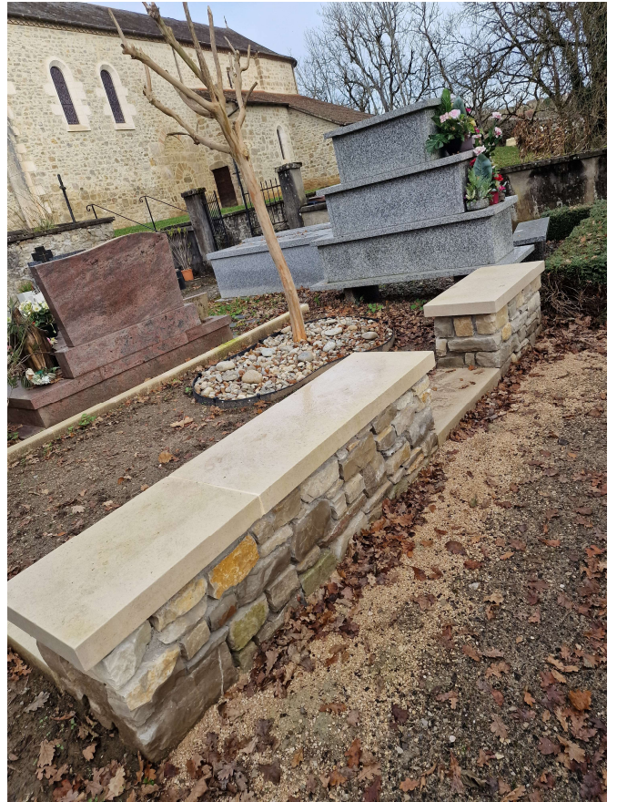
En cours de réalisation
