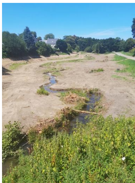
Le Ruisseau de la Hirlais après travaux
