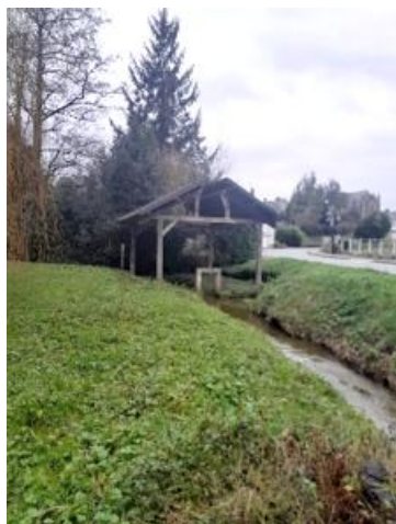
Le lavoir (avant travaux)
