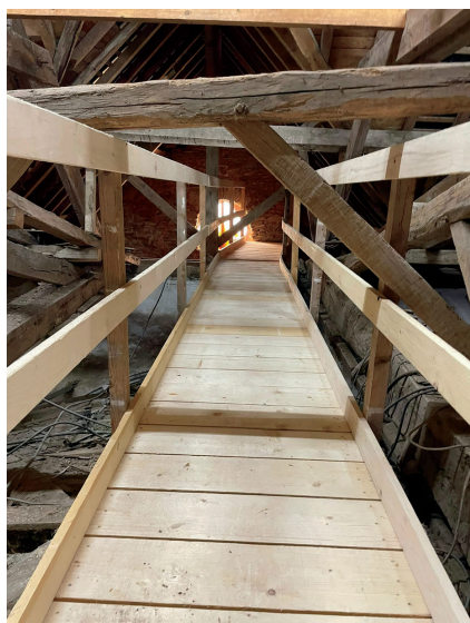
Le chemin des combes permettant de relier le clocher à l'autre côté de l'église.
