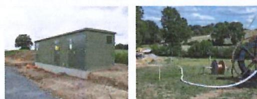
Des tranchées sont creusées afin de poser les câbles qui relient les éoliennes entre elles. Un poste de livraison de l'énergie électrique est installé sur le site. Les équipements sont ensuite raccordés à celui-ci.
