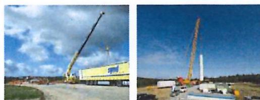
Le transport des différents composants de l'éolienne se fait par convois exceptionnels. Le montage des composants (mât, nacelle puis pales) est réalisé grâce à une grue de levage de très forte capacité. C'est la dernière phase du chantier avant la mise en service du parc.
