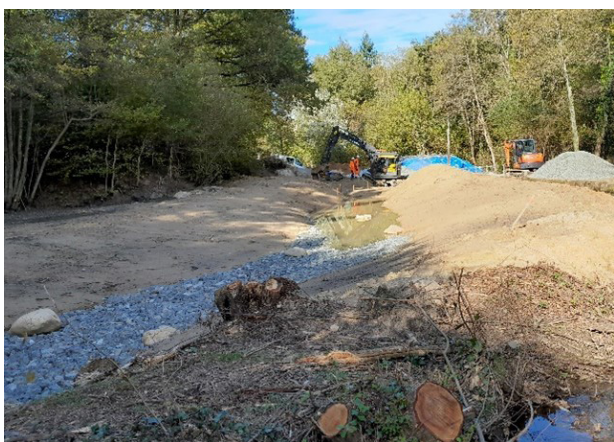
Travaux en cours : création du nouveau lit du Gourcet dans l'ancien étang et passage routier
