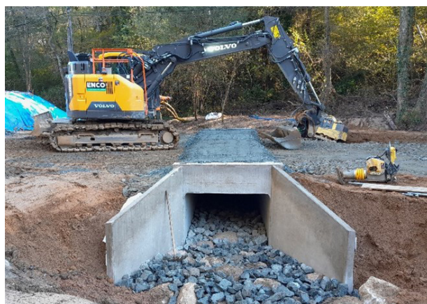
Travaux en cours : création du nouveau lit du Gourcet dans l'ancien étang et passage routier
