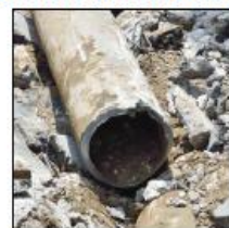
Conduits amiante ciment
