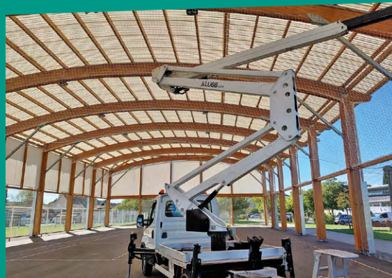
Sous la halle, les agents communaux ont posé un filet pour protéger la toiture.
