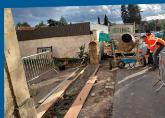
Espace Santamaria : réalisation d'un seuil en béton et pose d'un portail; réfection du sol de la bibliothèque.
