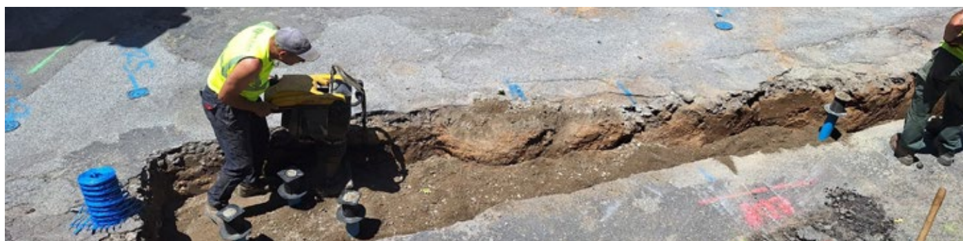
Les travaux ont démarré Place Gabriel Péri
