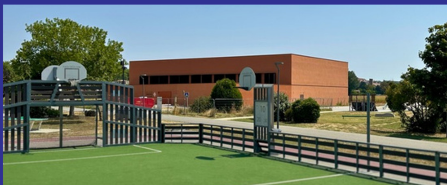
Complexe sportif de la plaine d'Amont
