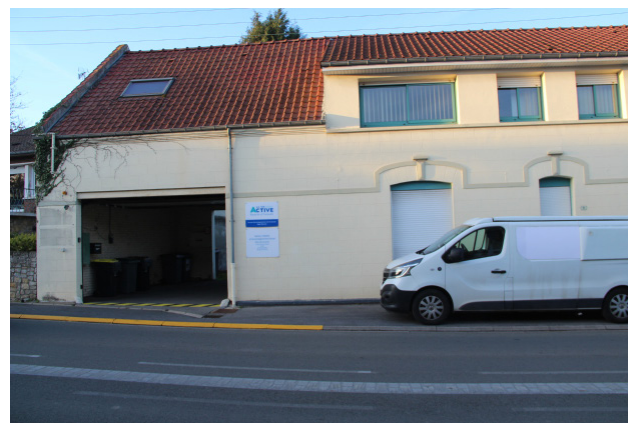
La direction départementale des foyers de «la vie Active» Roger BERNARD rue J.Jaurès
