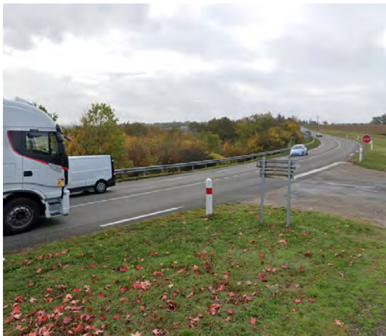
Un exemple d'accès dangereux, depuis la route du moulin d'Arasse à Foulayronnes (croix de Roudé)
