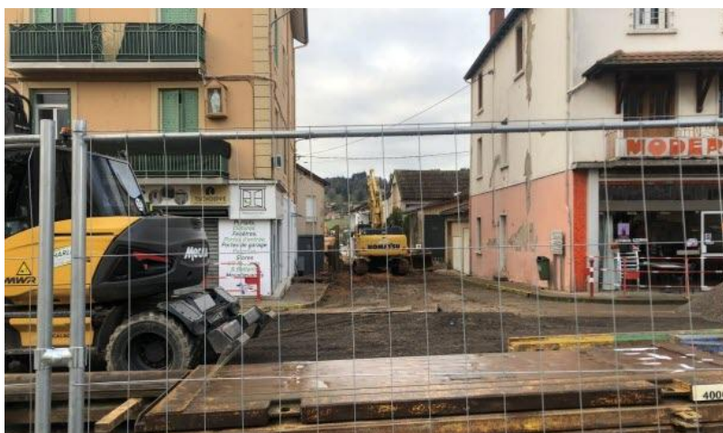
La rue Victor-Hugo en travaux. Photo Didier Bourgeon
