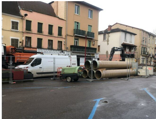
Les futures canalisations souterraines sont entreposées. Photo Didier Bourgeon
