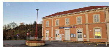
Le bâtiment de la gare de Chauffailles abrite les services du Pimms. Celui-ci n'ouvrira pas son hall au-delà des horaires habituels. Photo Noémi Predan
