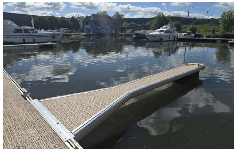
Nouveaux pontons installés au port de plaisance de Port-sur-Saône
