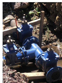
Branchements sur le nouveau réseau d'eau potable.
