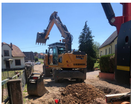
Au niveau du pont de la Hasel, les eaux pluviales provenant des hauteurs de la rue du Moulin ont été raccordées à l'installation existante pour être dirigées vers la Hasel.
