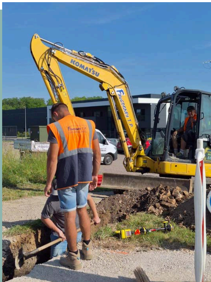
Travaux de terrassement réalisés par l'entreprise Faucogney TP devant la société RFPM
