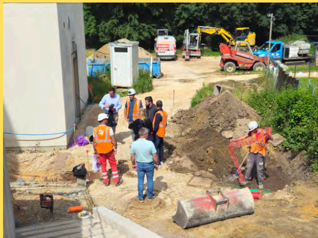
Visite hebdomadaire de la commission Enfance sur le chantier
