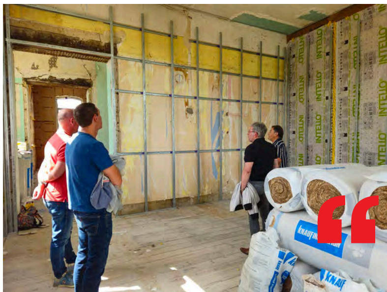
2 e phase de travaux en cours
