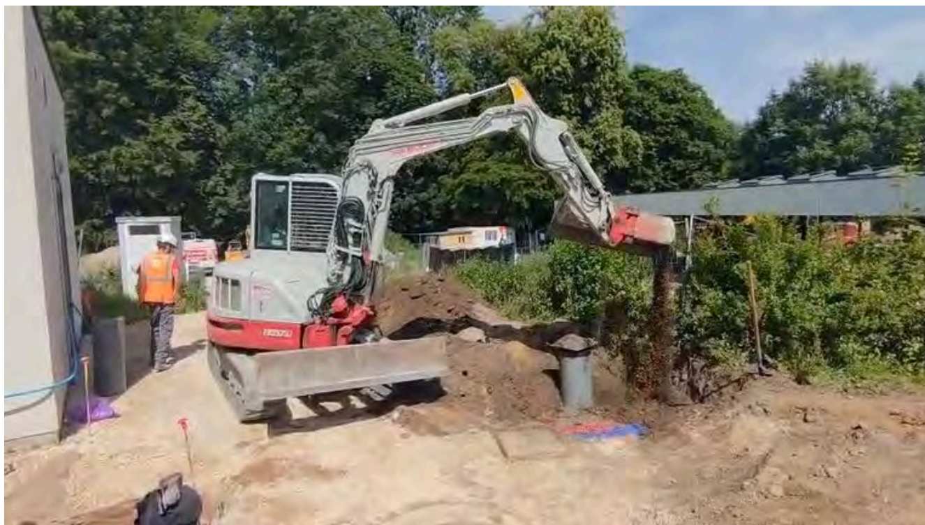
Travaux de terrassement.
