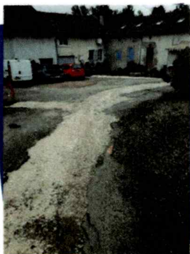
RENOUVELLEMENT DE L'HYDRAULIQUE LAUTERIE PIEGUT PLUVIERS
