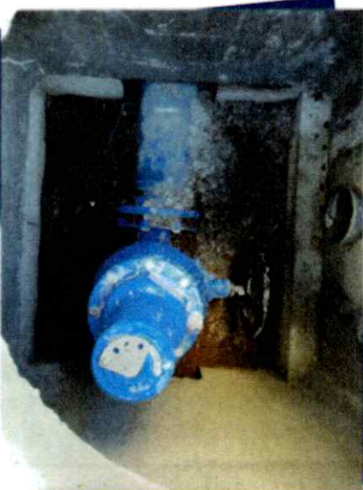
POSE D'UNE VANNE ET SOUPAPE AU RESERVOIR D'AUGIGNAC
