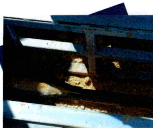
RENOUVELLEMENT DE L'HYDRAULIQUE PAR ECLATEMENT ROUTE DES GRENOUILLES PIEGUT PLUVIERS
