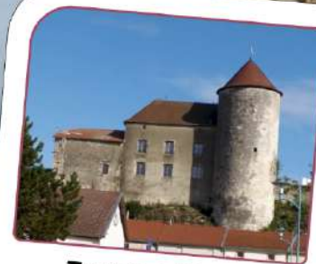
Tour médiévale Gondrecourt-le-Château
