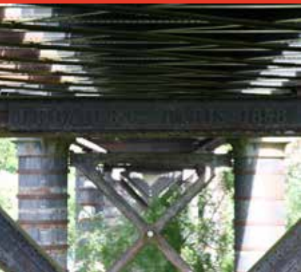
Détails du pont de fer, Moulins
