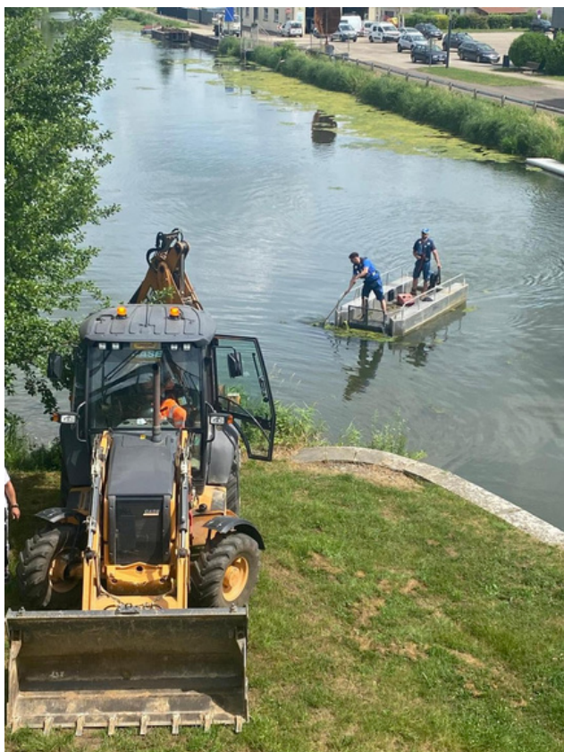
Nettoyage du canal- accès au port de plaisance
