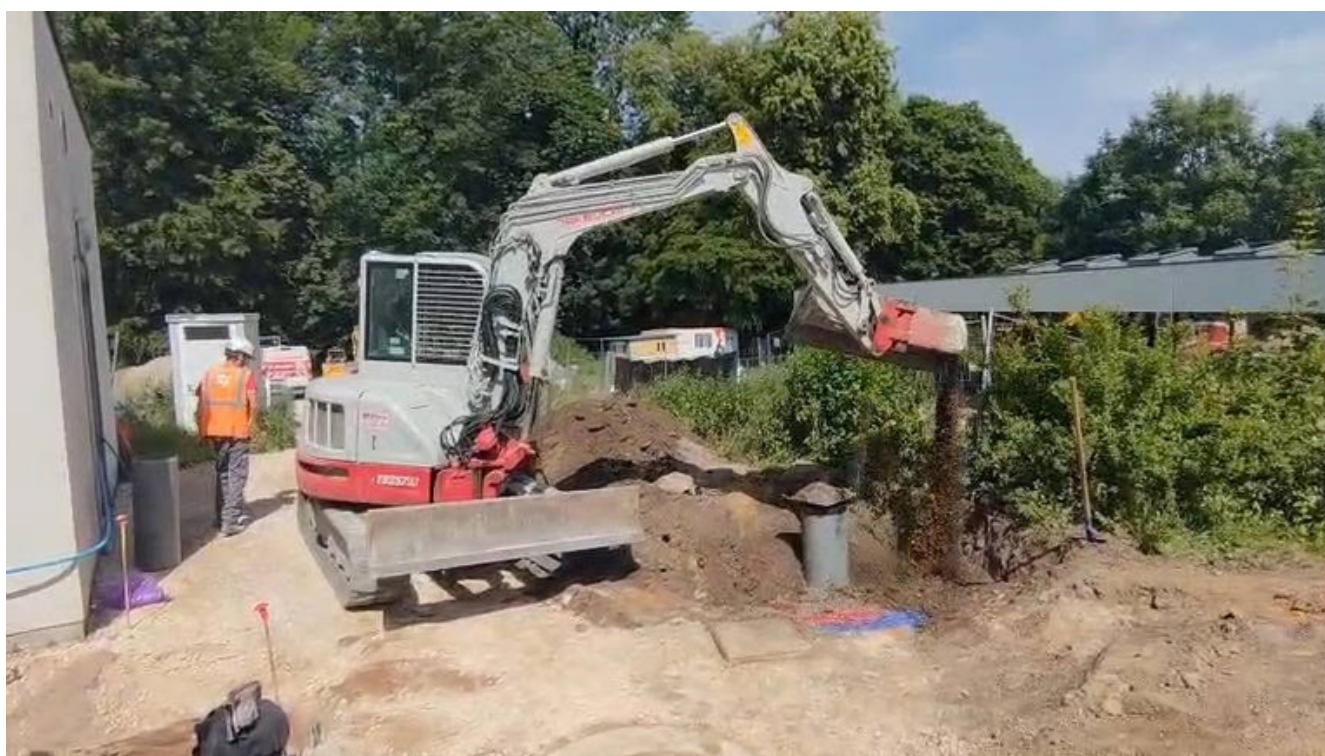
Travaux de terrassement.
