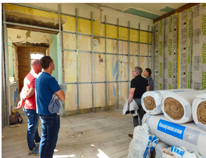
La visite du chantier se poursuit dans les salles de classe en réfection.
