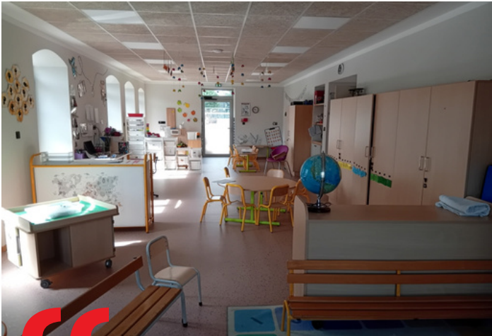
1 re partie des travaux terminés avec les classes de maternelles
