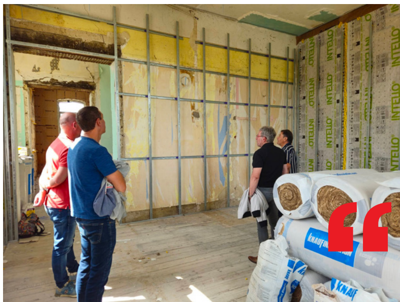
2 e phase de travaux en cours
