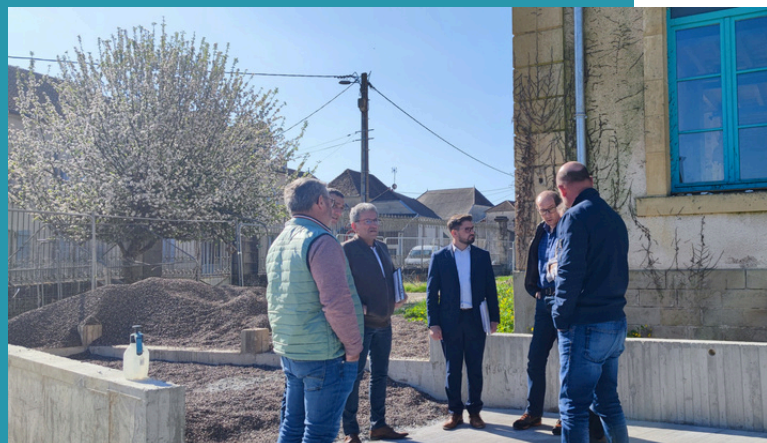
Visite sur le chantier des écoles à Amance
