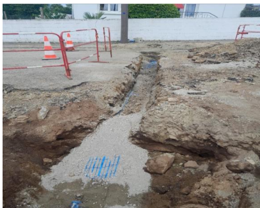
Renouvellement bcht plomb avec compteur mis en extérieur
