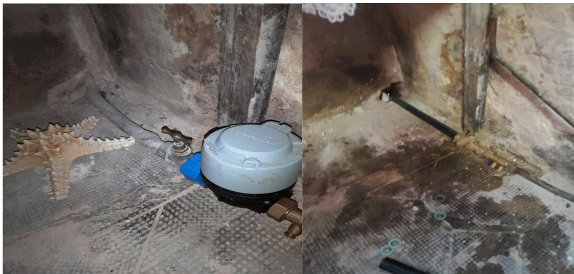
Renouvellement bcht plomb avec compteur mis en extérieur
