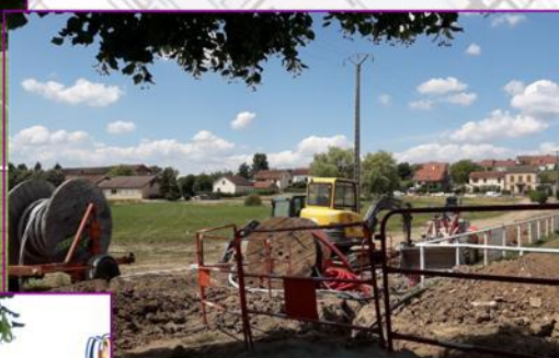
Couverture du fossé du stade et mise en souterrain de la ligne électrique
