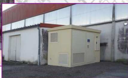
Renforcement du réseau électrique et mise en place d'un nouveau transformateur
