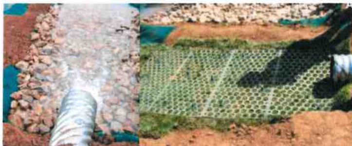
Dispositifs temporaires de protection des points de rejet à l'aide de tas de graviers (à gauche) ou d'un tapis laminaire PEHD (à droite) (Source : Extrait du Guide de protection des milieux aquatiques en phase chantier de l'AFB)
