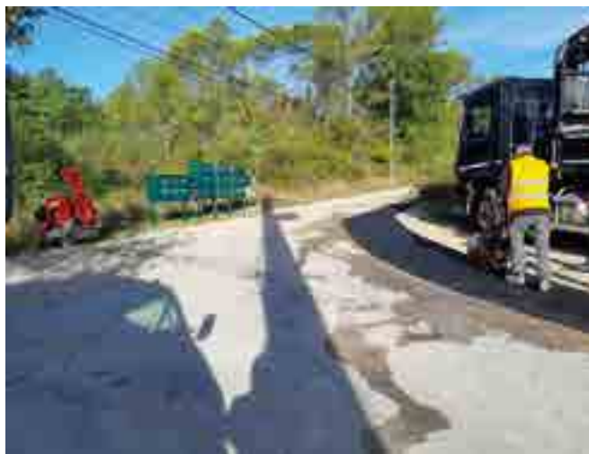
Réfection de l'intersection chemin de la Cabrore et chemin de la Crac
