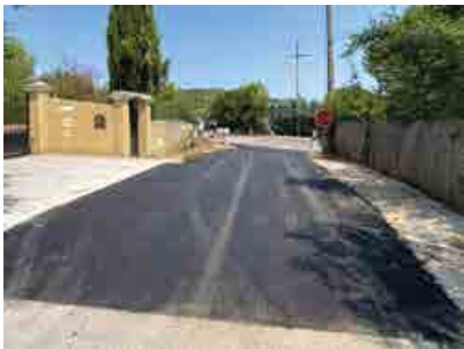
Entrée du chemin du Tonnier
