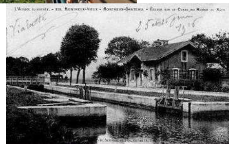
Écluse de Montreux-Vieux Château (début XX e )
