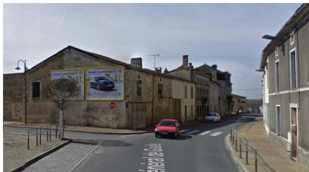
Bâtiment préexistant démoli
