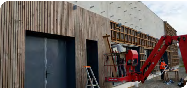
Pose du bardage bois
