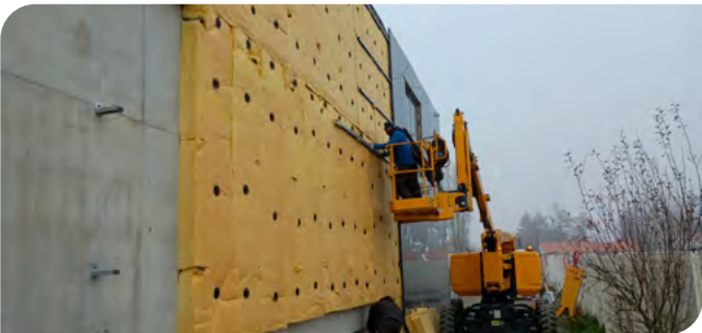
Pose du bardage métallique
