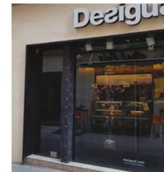
La protection de la vitrine par du vitrage antieffraction permet de s'affranchir d'autres dispositifs de protection.
