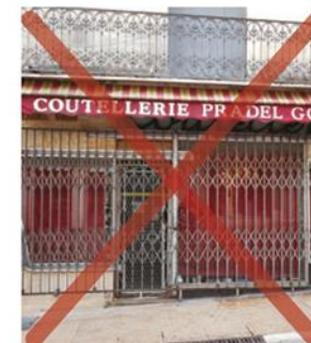
La grille de protection ne peut pas dépasser de la baie commerciale et recouvrir le mur du rez-de-chaussée de l'immeuble.
