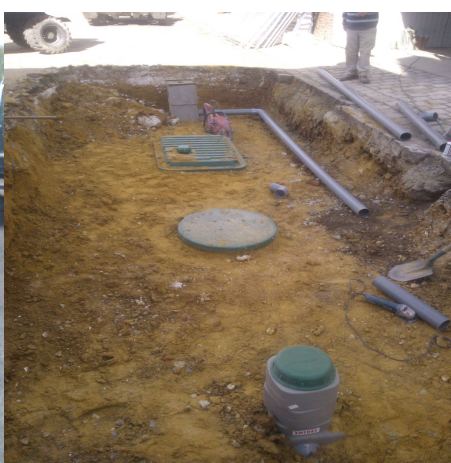
Photo 2 : installation après remblaiement
