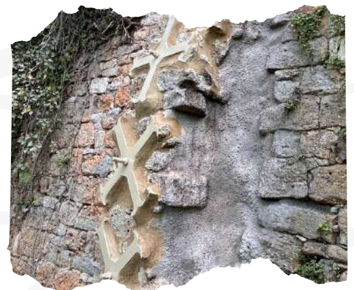
exemple de réalisation
