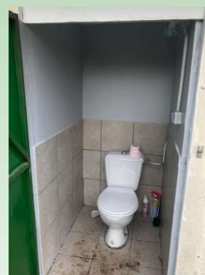
Toilettes extérieur accessibles à tous ré-isolées, remises à neuf avec lumière et serrure de nouveau fonctionnelle.
