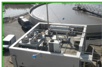
Centrale de cogénération
