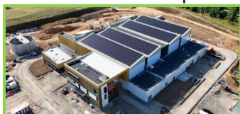
Etat du chantier en juin 2025
