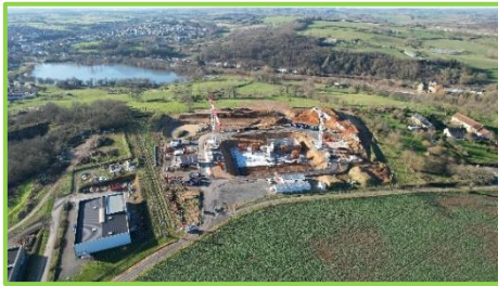
Usine des Eaux – janvier 2024
