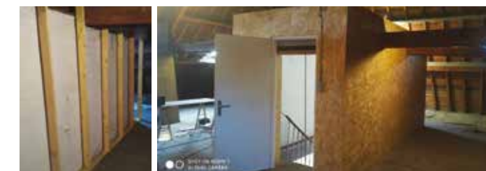
Création cloison isolée + isolation place Gaulard
