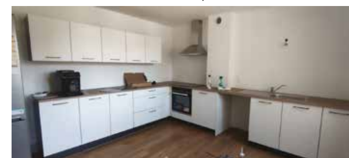
Installation d'une cuisine
