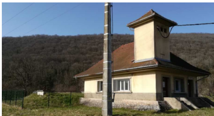
Station de pompage de Branne
