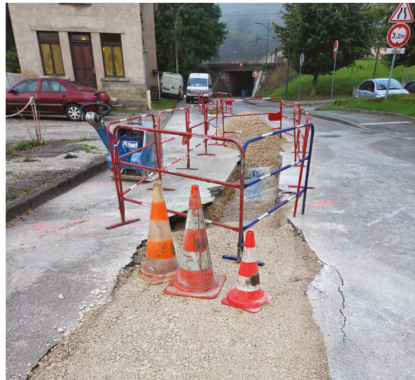
Travaux de réhabilitation de la conduite d'eau potable à Pays-de-Clerval, rue Leonel de Moustier
