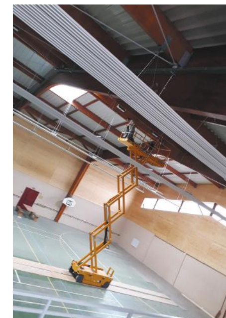
Travaux en cours au gymnase de Pays de Clerval
